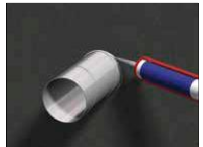
D6. Fuging rundt gjennomføringer
